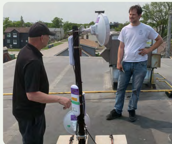
Instalando antenas en el North End de Winnipeg © Capítulo Canadá Manitoba
