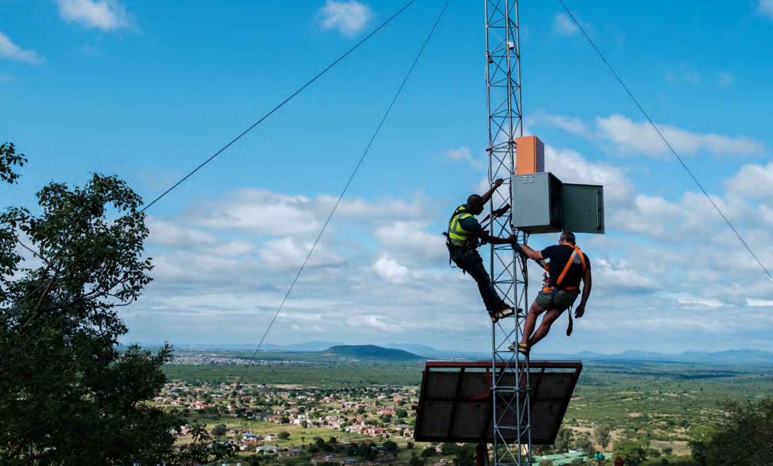
Pardon Mabunda (à gauche) et Stephan Jacobs, en train de préparer l'installation de batteries supplémentaires afin d'améliorer la fiabilité d'une tour appartenant au réseau communautaire de Mamaila, sur une colline au-dessus du village de Sephukubje, dans la province de Limpopo, en Afrique du Sud
