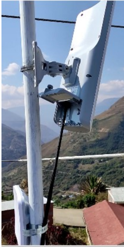
Instalacion de las Antenas
